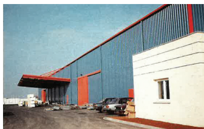
Hall de stockage produits finis fenêtre.
